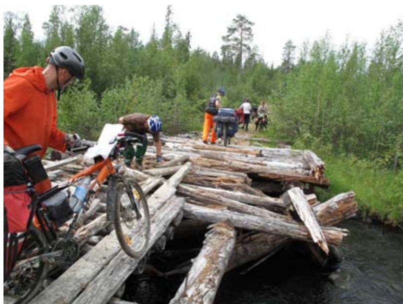
Фото 8. Мост через приток р. Вяла.
