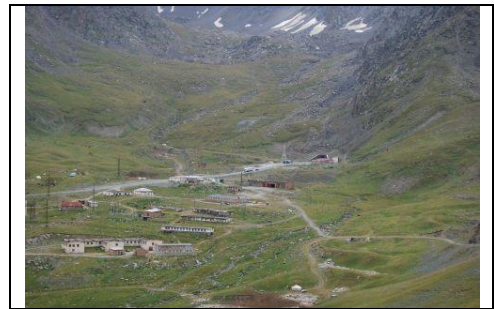
4. Вид на тоннель через пер. Тёо-Ашуу
