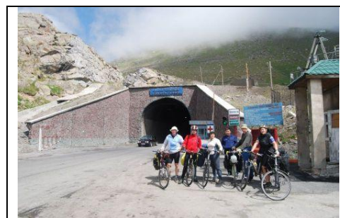
14. У выезда из тоннеля
