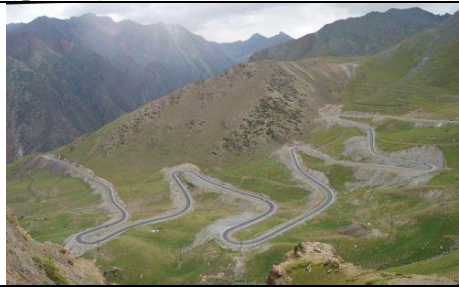
3. Вид на серпантин перед тоннелем через пер. Тёо-Ашуу
