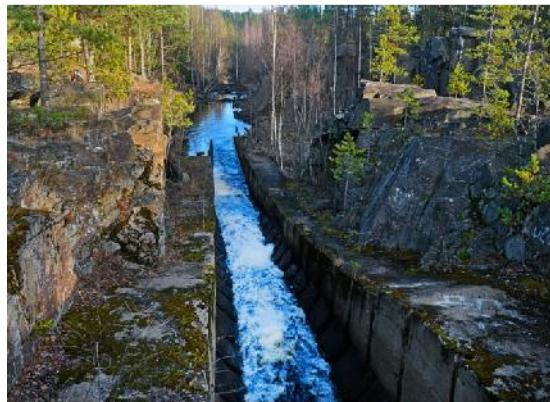
Рис. 6.7. Лоток для сплава брёвен
