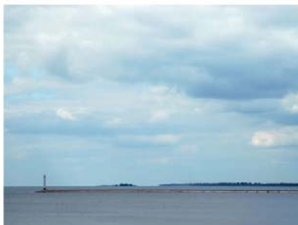
Фото 6. Киевское море (водохранилище) возле ГЭС
