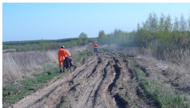
Фото 4-02. Дорога после Быково-Репинка
