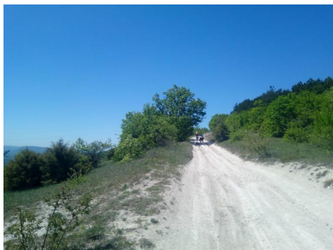
2.Съезд на грунт плохого качества
