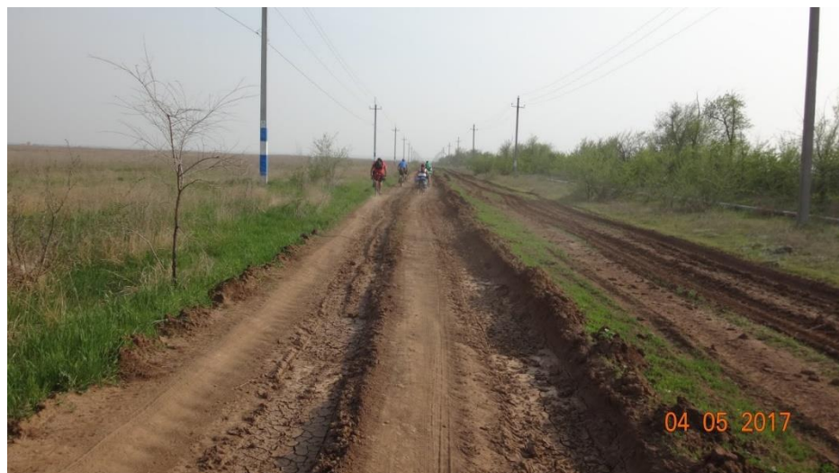
Грунтовая дорога вдоль канала
