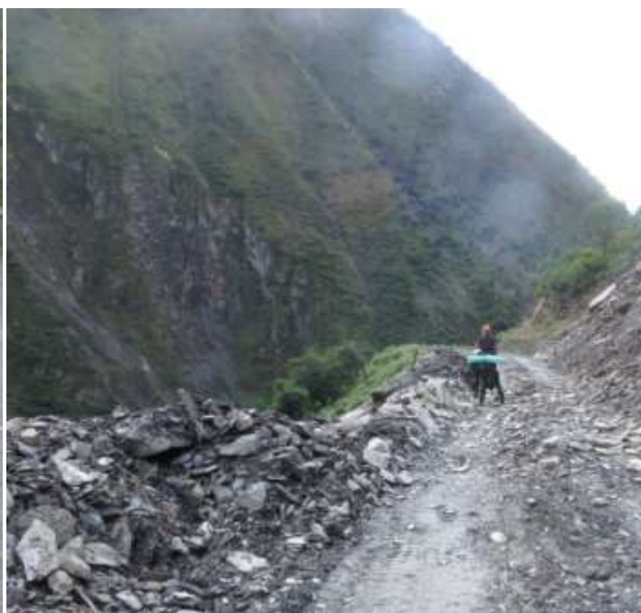
Участок каменной дороги
