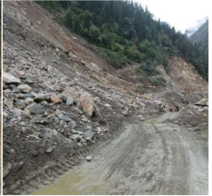
Осыпь на дороге
