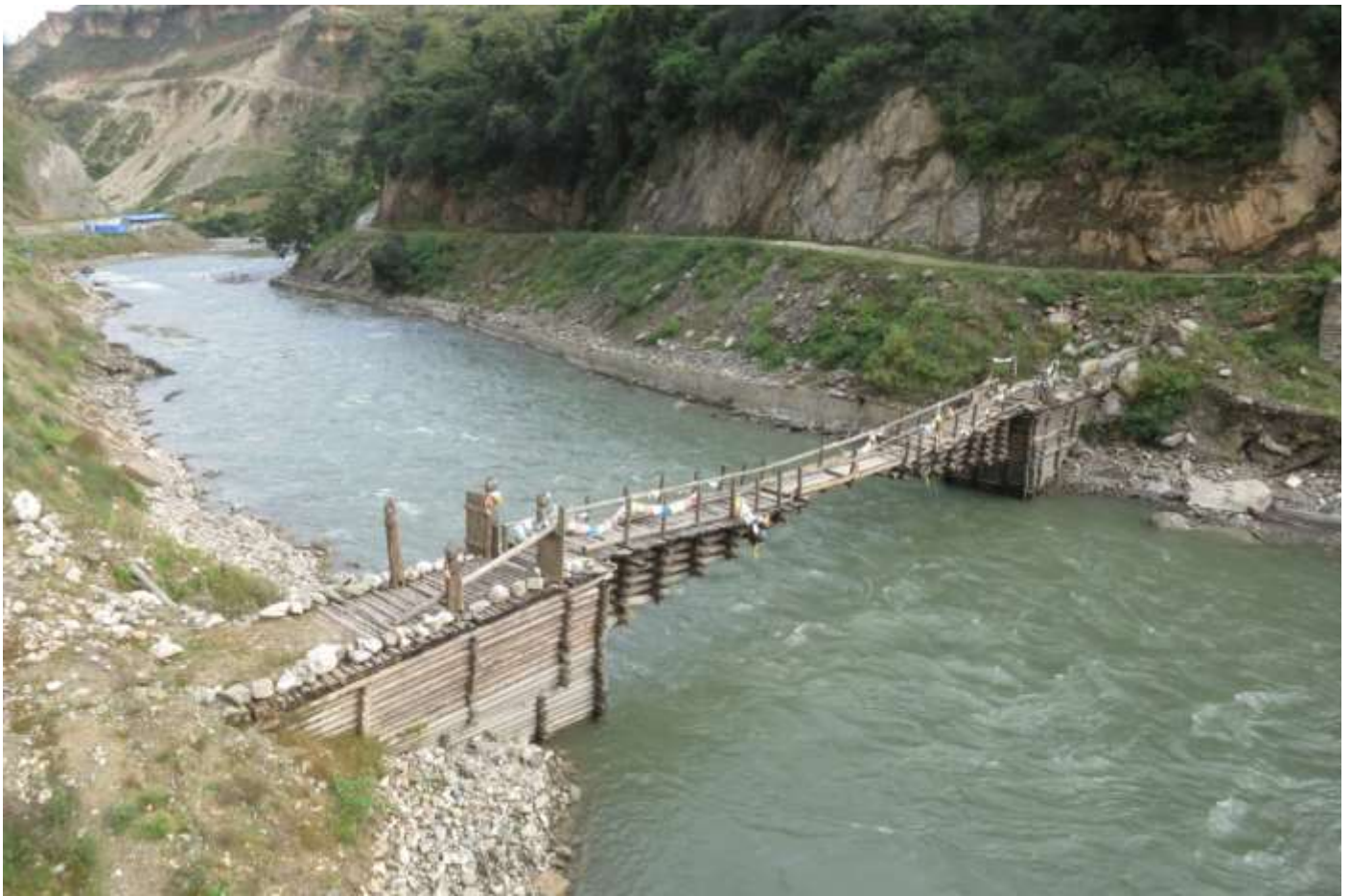
13 км - строительная техника, идут дорожные работы.
