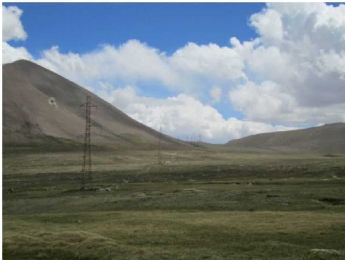
Рис. 49. Движение вдоль ЛЭП
