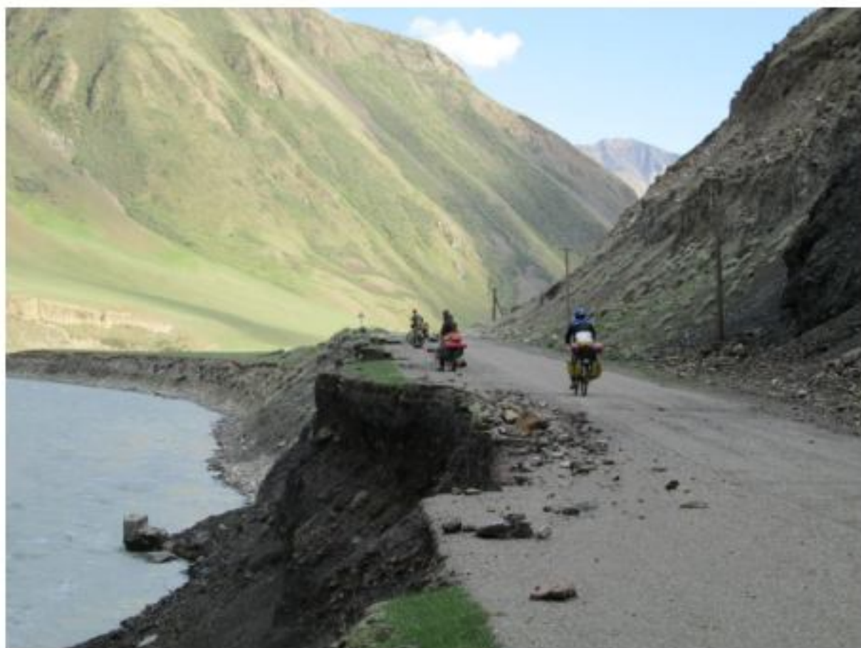
Рис. 13. Дорога постепенно разрушается
