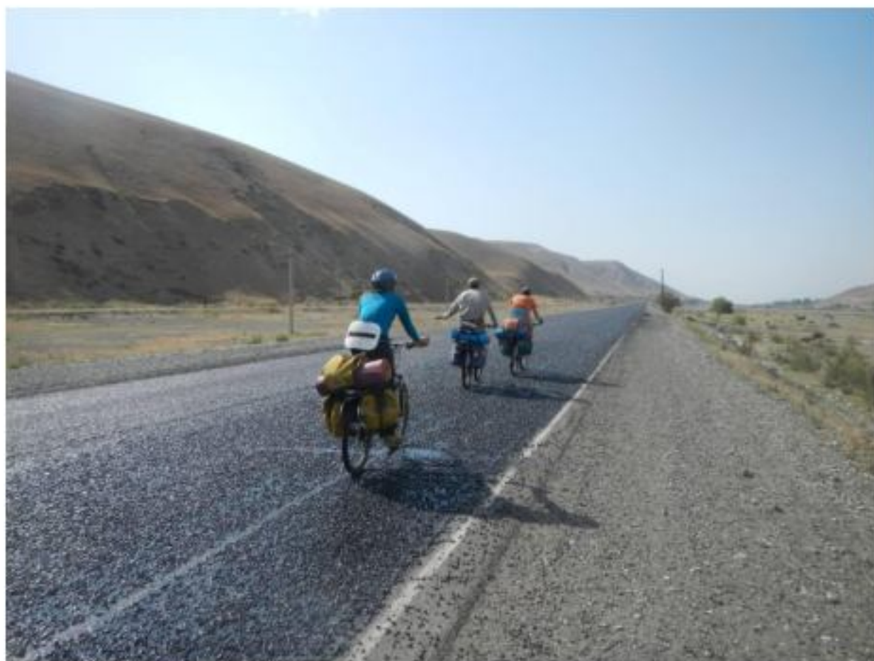
Рис. 144. Участок ремонтируемой дороги
