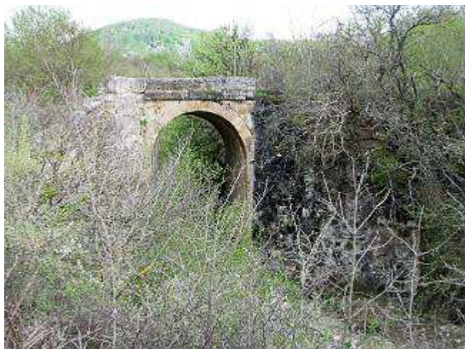
Фото 2.15 Локальный, но все равно капитальный мостик
