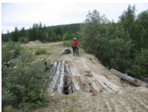
Мост в ур. Тихая Гавань
