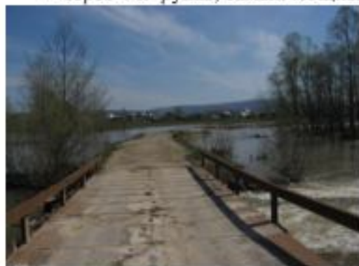
Мост через р.Аша. Вид назад
