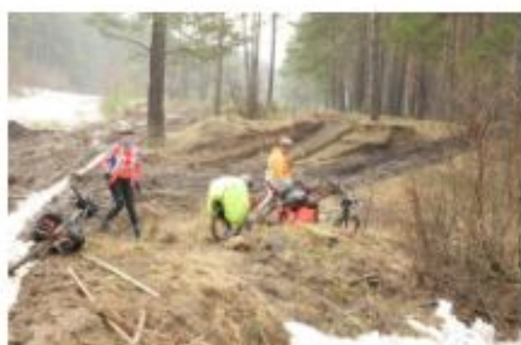
Дорога от моста
