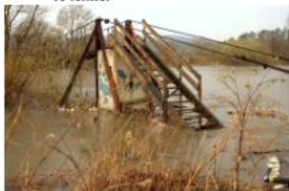
Подход к мосту затоплен
