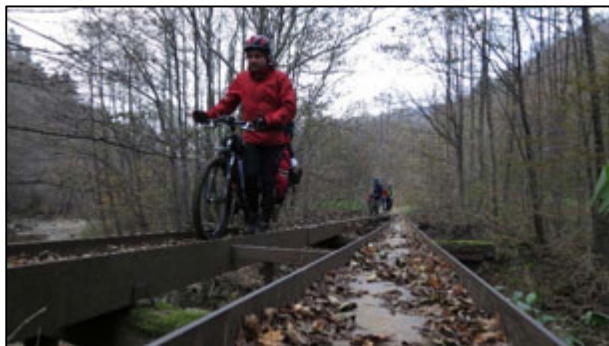
Высокий мост из двутавров
