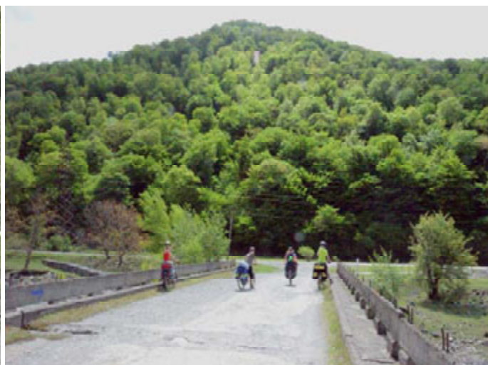
Мост на трассу перевал - Гудрухи
