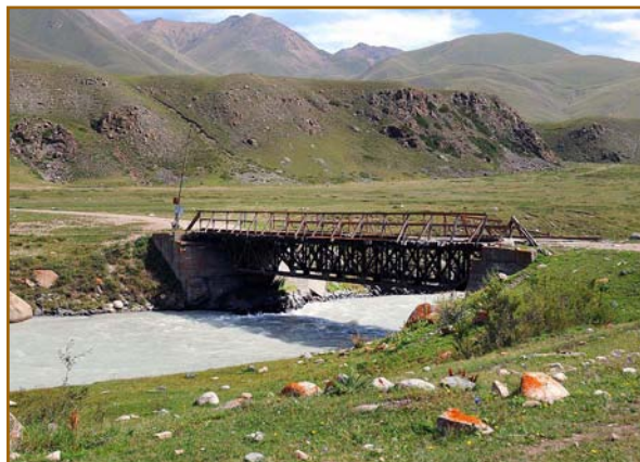
Деревянный мост через реку Чонг-Кемин
