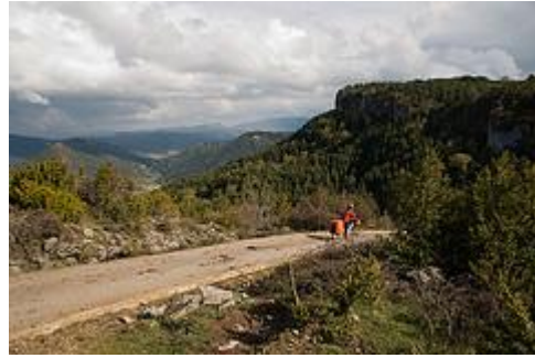
С перевала вниз дорога забетонирована.
