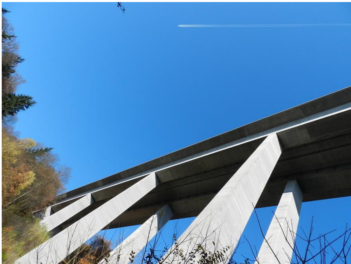
Автодорожный мост над лесной велодорожкой
