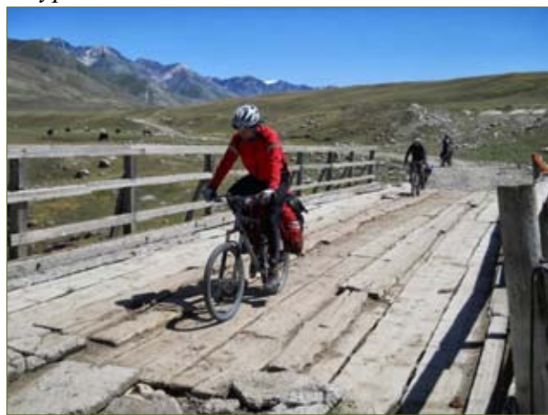
Мост через р. Джилусу
