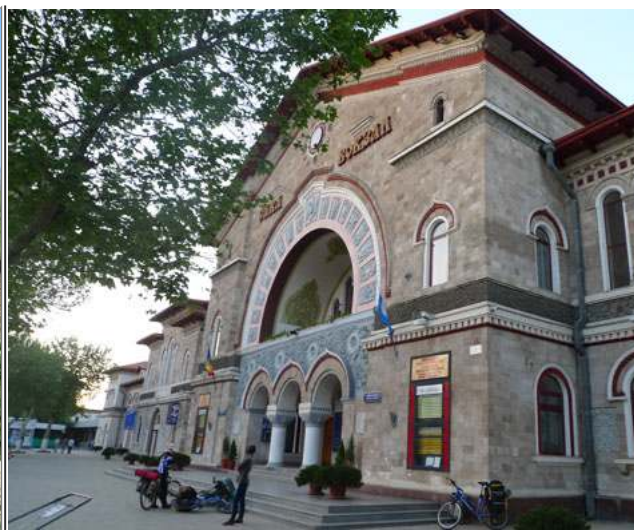
ЖД вокзал в Кишиневе.
