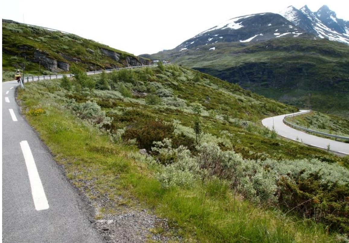
Фото 40. ПП2. Подъем на 1434м.
