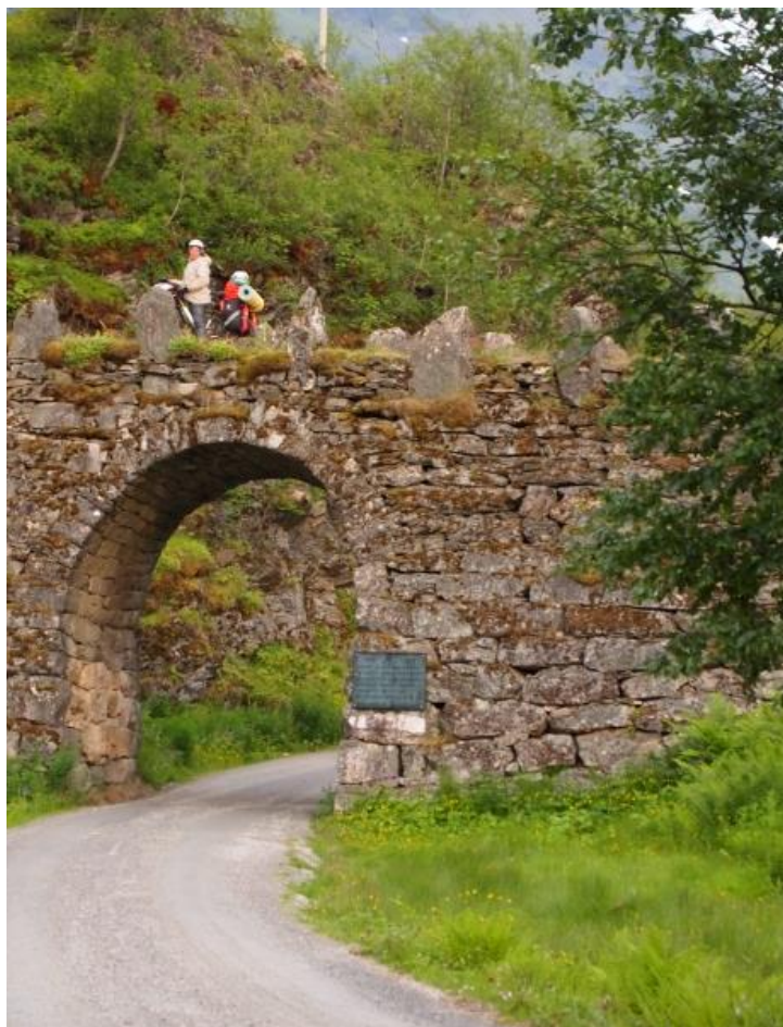
Фото 42. ЛПЗ. Подъем к Далсниббе
