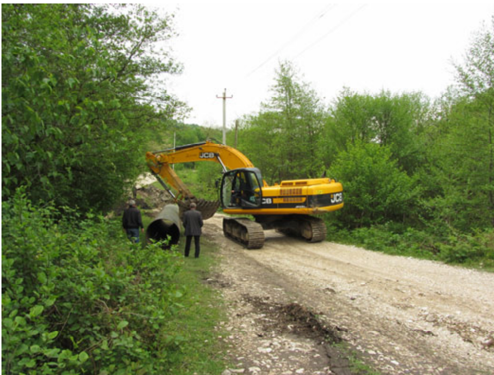
5. Ремонт смытого моста
