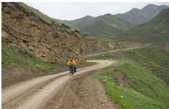
26.Грунт х/к (подъем на перевал)
