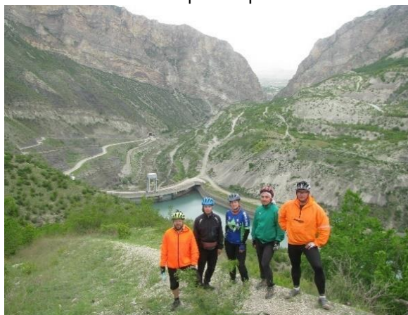
4.Вид на плотину Миатлинской ГЭС
