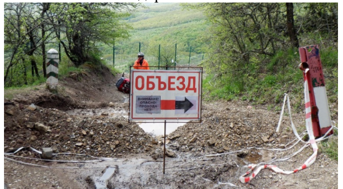
16.перекопанная дорога, проезд закрыт
