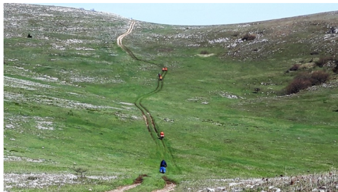
10.Дорога разбитая, чередование камня и грунта
