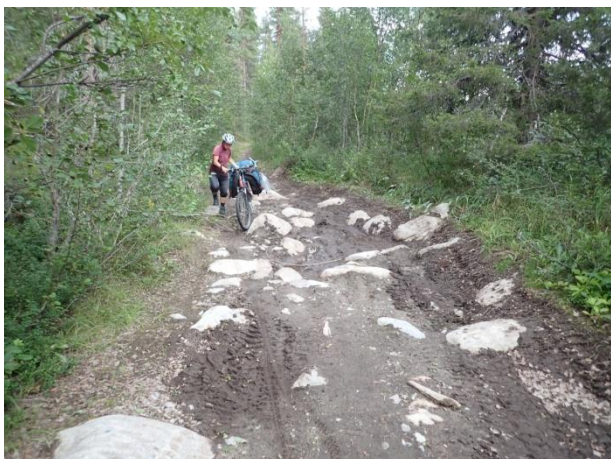
7.Грунт с ТП
