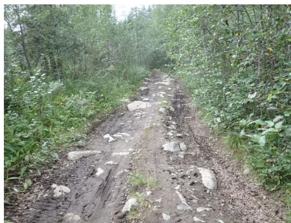
8.Грунт с ТП
