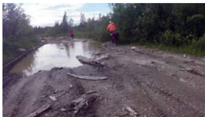
8. Грунт разбитый с ТП, мокрый
