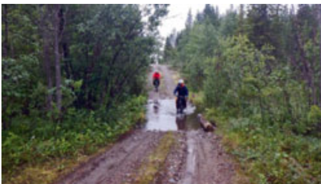
1. Грунт разбитый с ТП, мокрый
