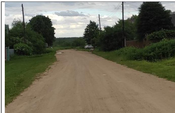
Участок грунтовой дороги
