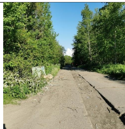
Фото 15. Старая бетонная дорога
