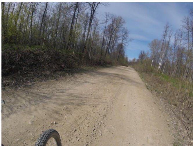
8. Грунт, дорога в хорошем состоянии, сухая
