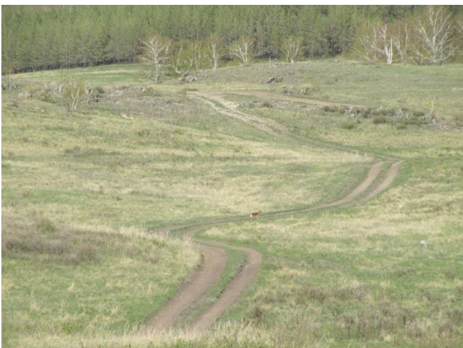
17. Грунт, дорога в хорошем состоянии, сухая
