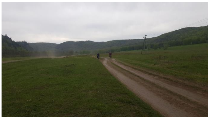
1. Грунт, дорога в хорошем состоянии, сухая
