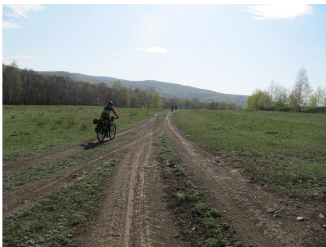
6. Грунт, дорога разбитая, сухая
