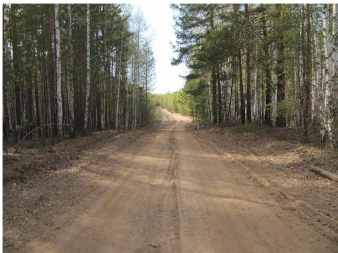
7. Грунт, дорога разбитая, сухая
