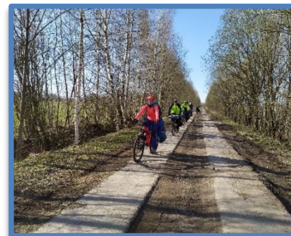
Фото 12 (старая бетонная дорога)
