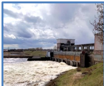
Фото 6 (водосброс на плотине)
