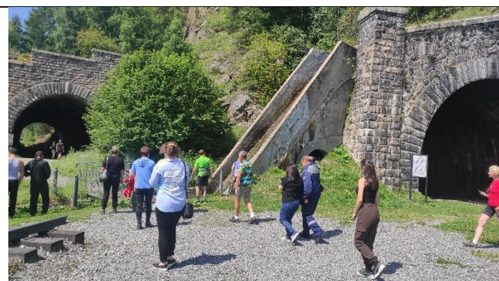
Инженерные сооружения железной дороги
